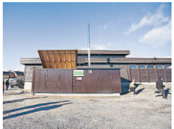
I SKOLEGÅRDEN. Ungene leker rundt flis-anlegget på Røren barneskole i Øvre Eiker kommune. Den ene delen av taket på den frittstående bygningen kan heises opp. Her fylles flisen i. Ovnene er i den andre enden.
